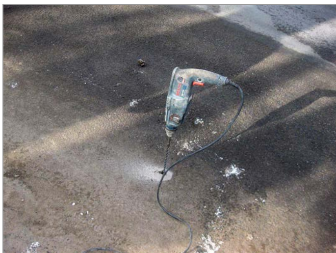
foto 23, 24: Ověřování skladky vozovky a jejího podloží v ploše mostu
