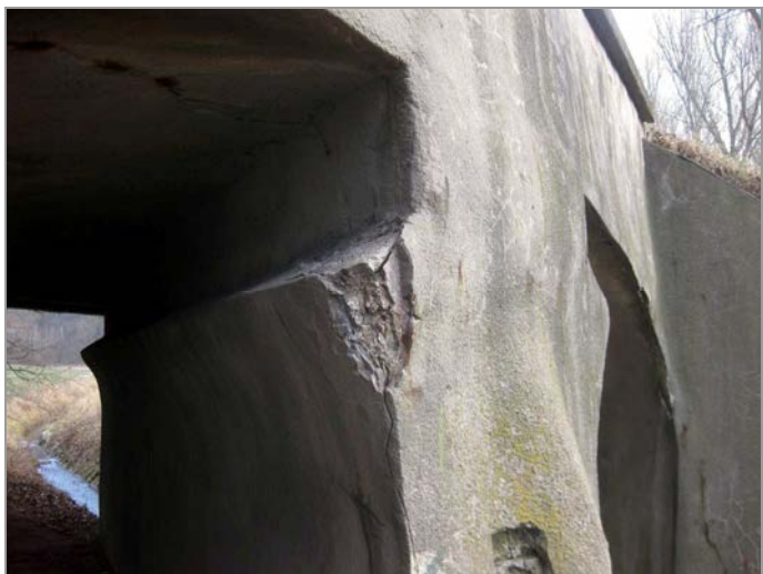
foto 1, 2: Pohled na původní (západní) část mostu - kamenné zdivo s betonovým nástřikem
