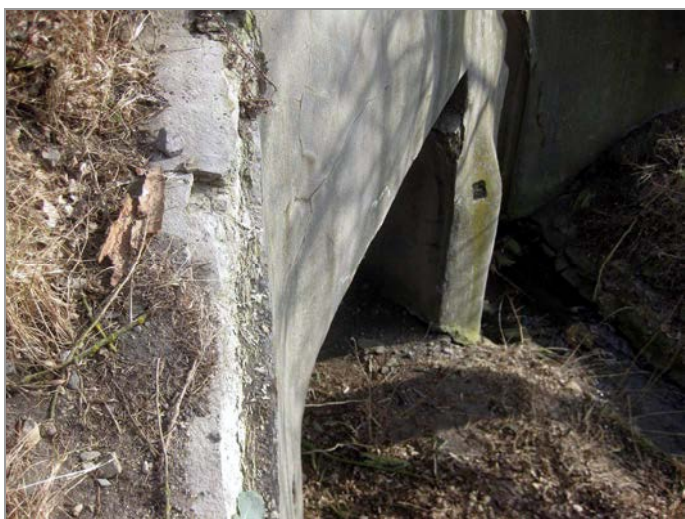
foto 5: Poškozené kamenné zdivo původní části mostu
