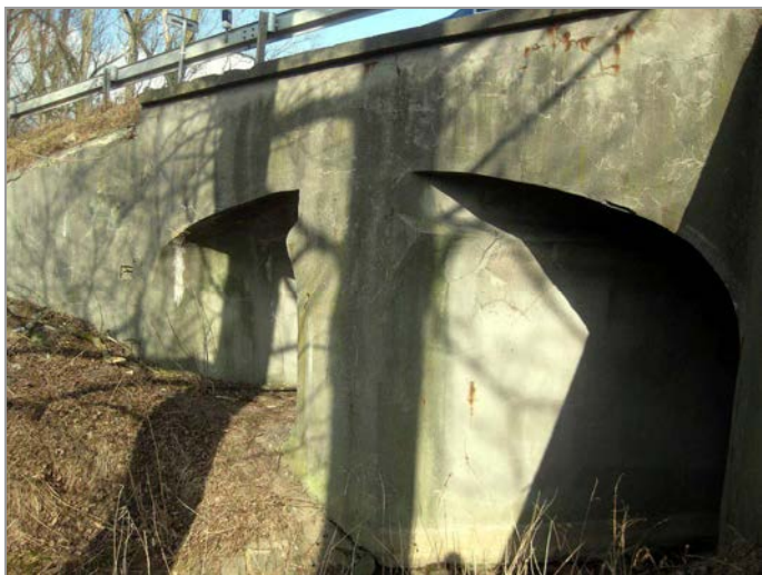
foto 1, 2: Pohled na původní (západní) část mostu - kamenné zdivo s betonovým nástřikem
